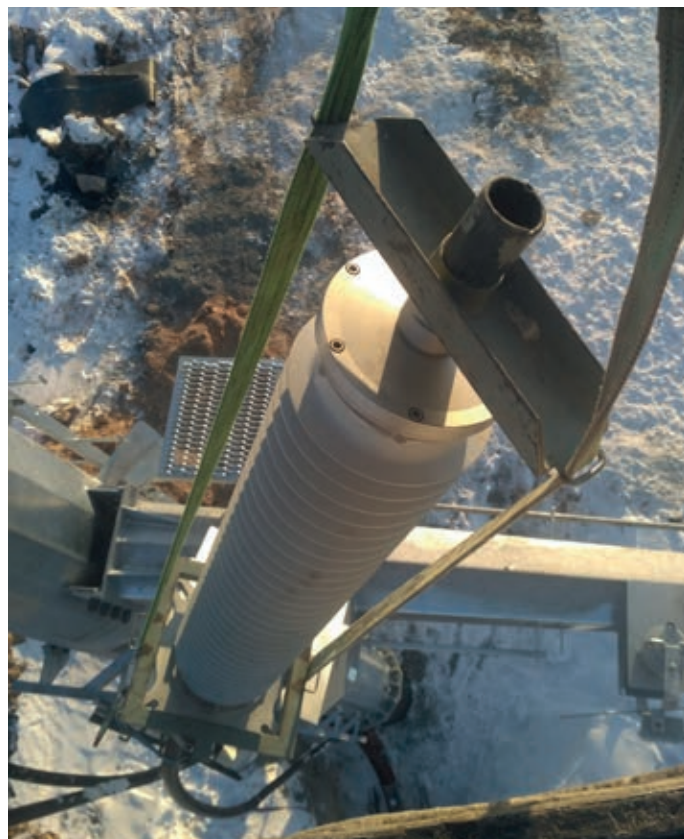
Установка концевых кабельных муфт на переходном пункте
