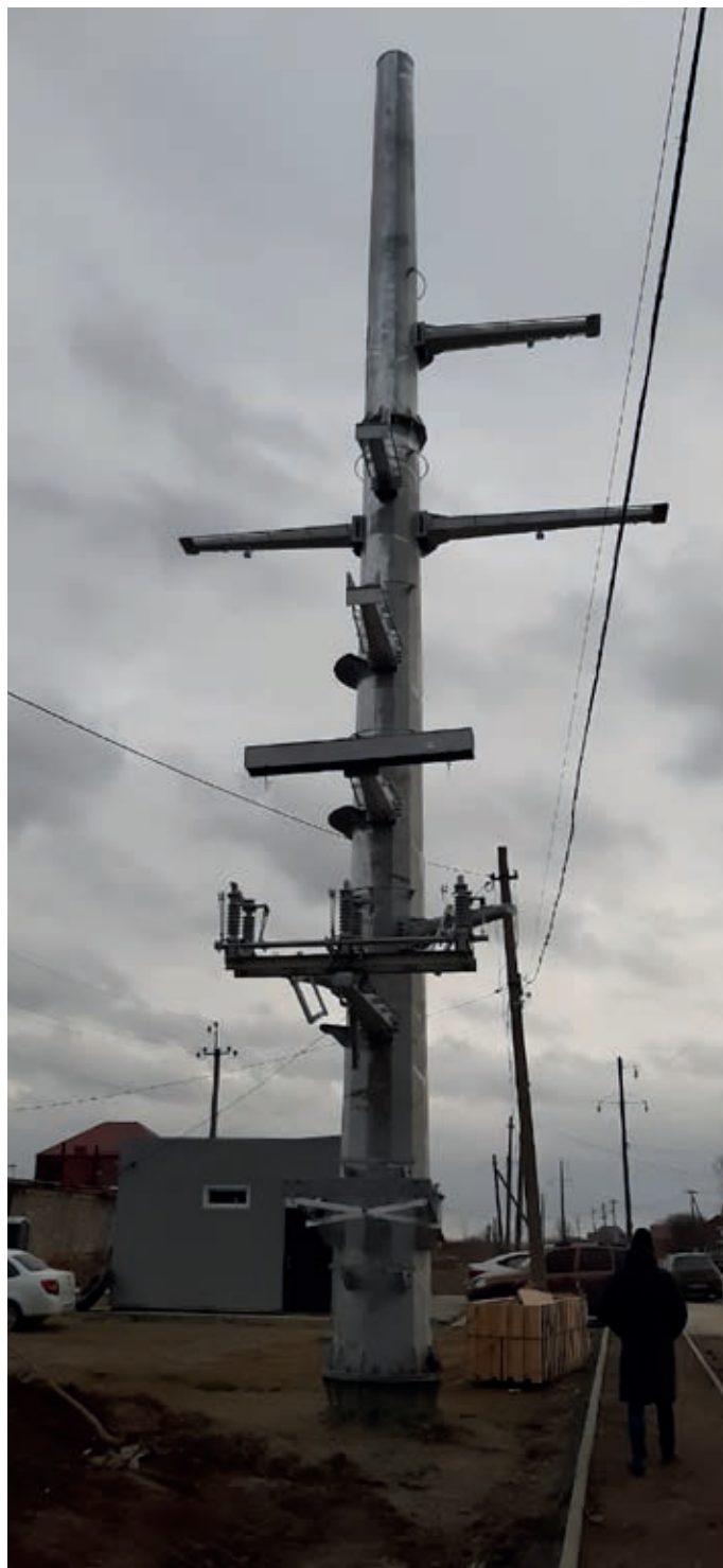
Монтаж ПКПО-КВ 35 кВ с разъединителем
