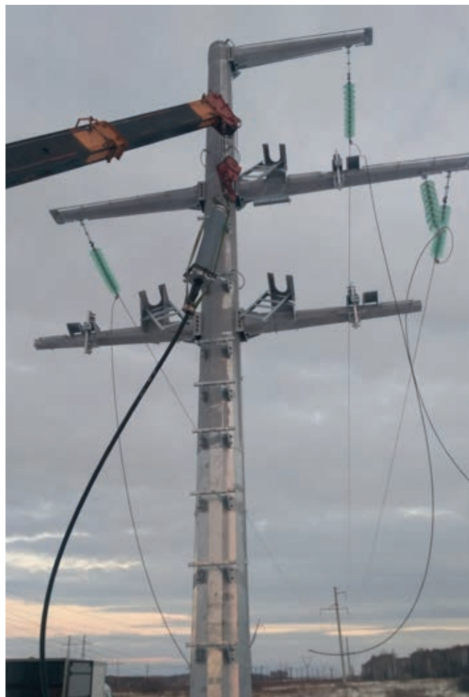
Установка концевых кабельных муфт на переходном пункте
