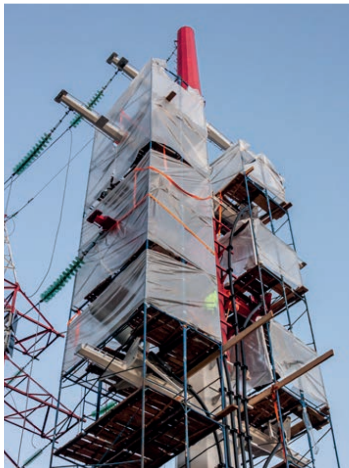
Монтаж концевых кабельных муфт
