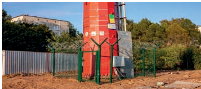
Установлен кабельный кожух, выполнено ограждение переходного пункта
