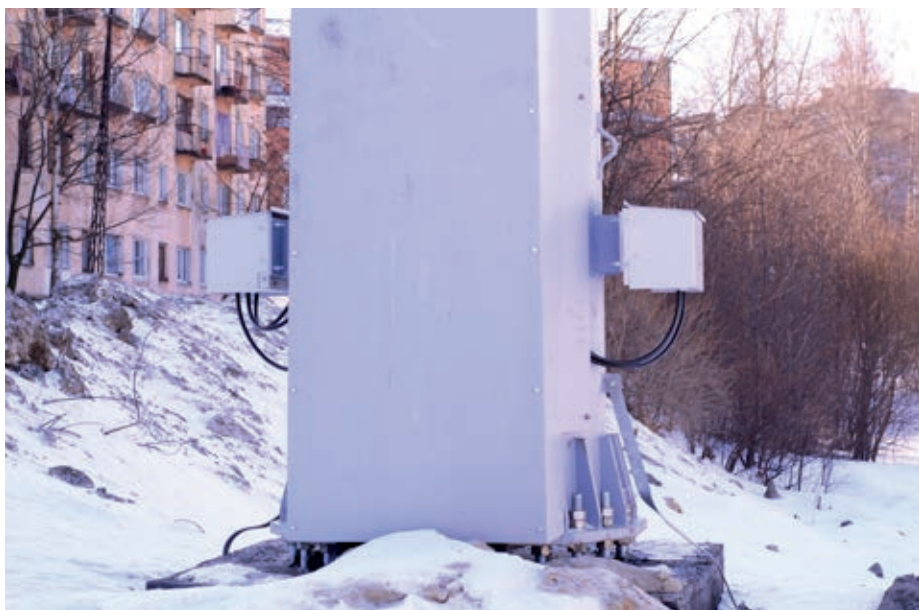
Переходной пункт установлен на отвесном берегу реки в скальном грунте. Применен монолитный железобетонный фундамент, усиленный анкерными закладными деталями.
