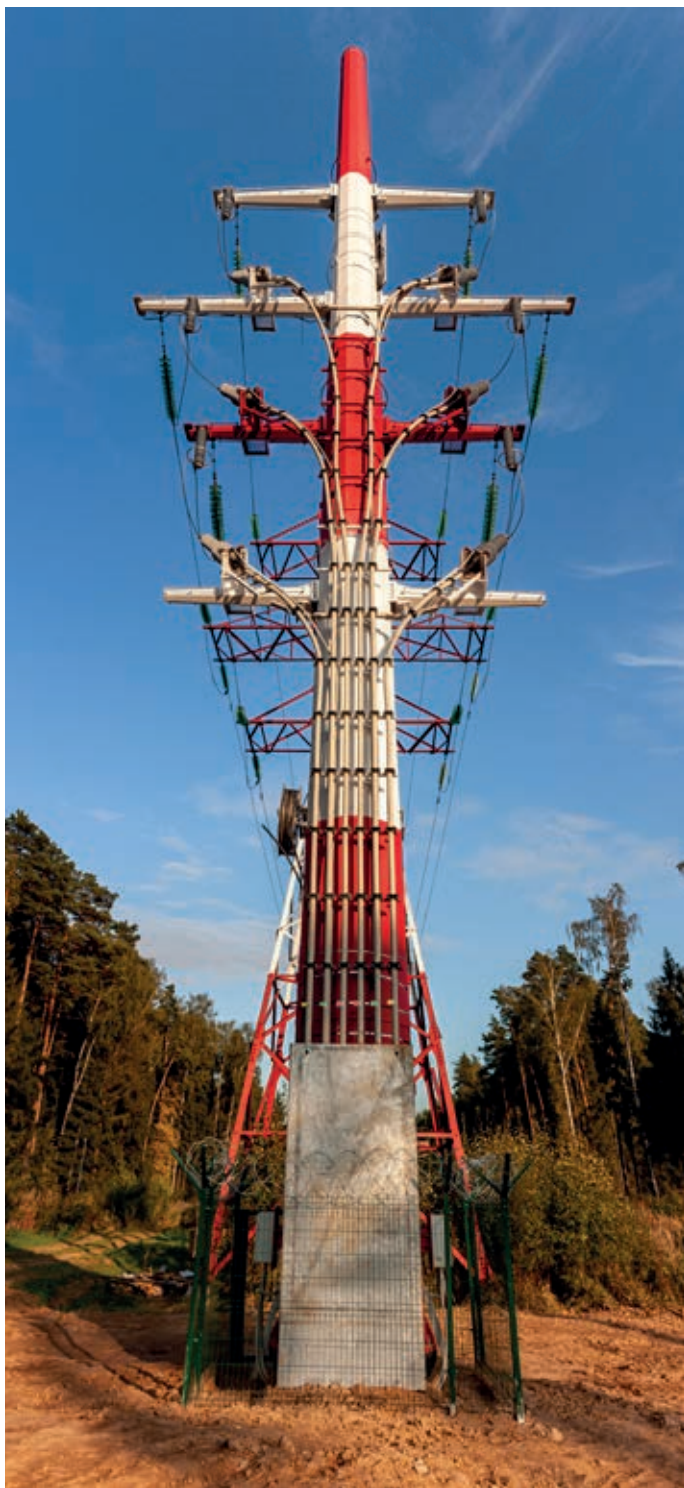
Установлен кабельный кожух, выполнено ограждение переходного пункта
